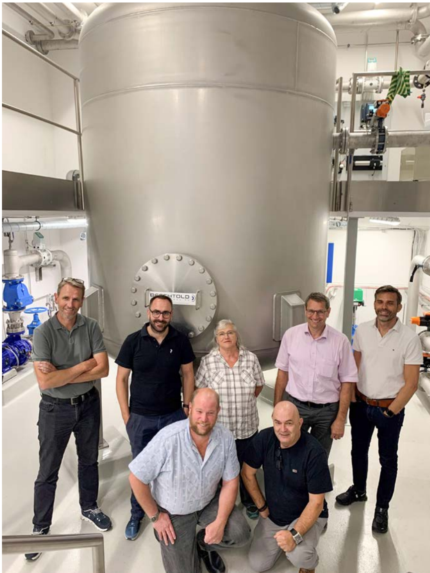
■ Der Gesamtgemeinderat anlässlich einer Begehung der Wasserversorgung.
