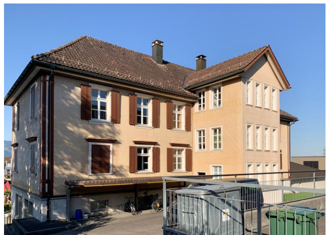
Das alte Primarschulhaus und heutige Kindergarten soll saniert werden.
