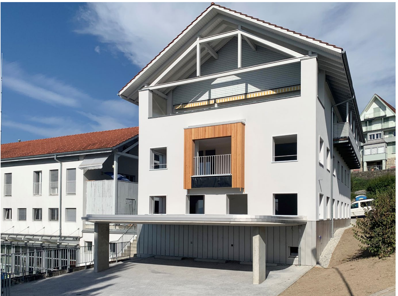
Im ehemaligen Gemeindehaus Rieden wurden zwei Wohnungen eingebaut.
