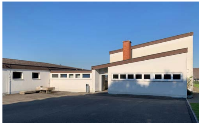
Nördlicher Eingang zur kleinen Turnhalle im OSZ II.
