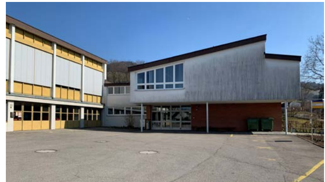
OSZ II mit ehemaligem Feuerwehr-Depot.
