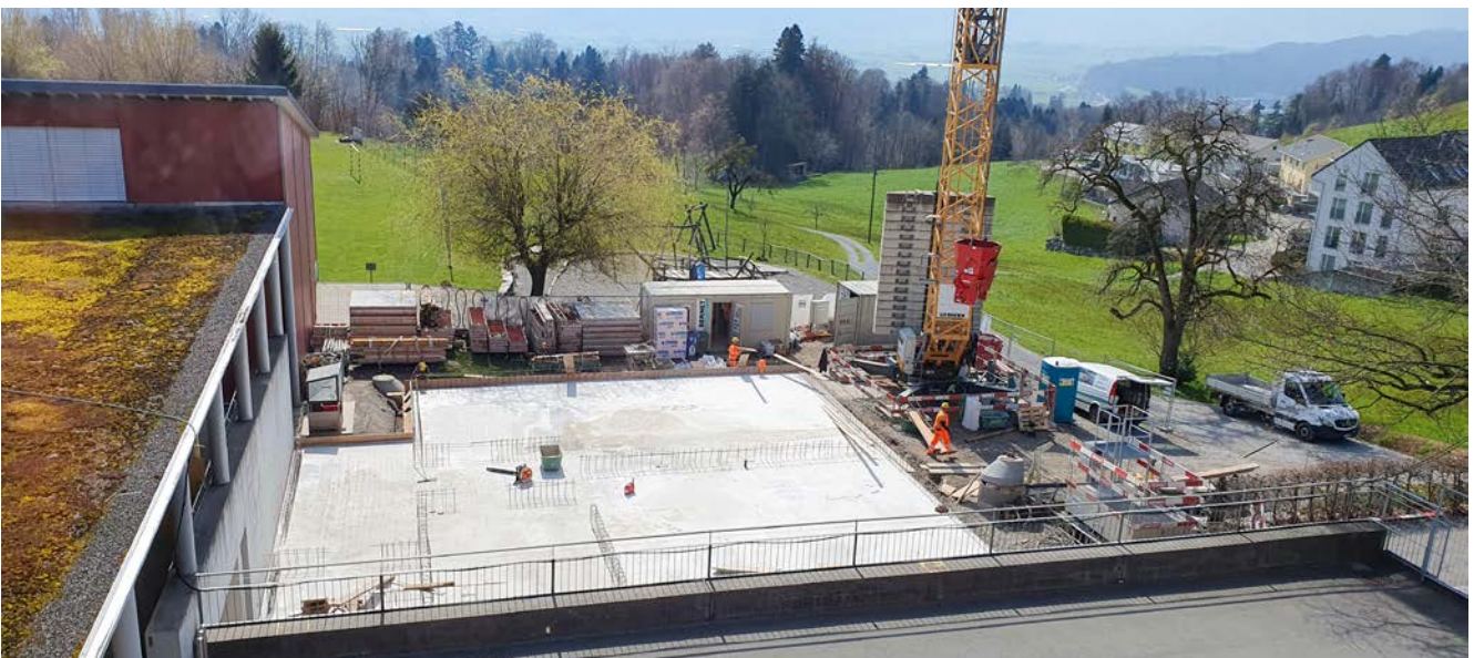
■ Der Baustart des Erweiterungsbaus bei der Schule Ernetschwil ist erfolgt.
